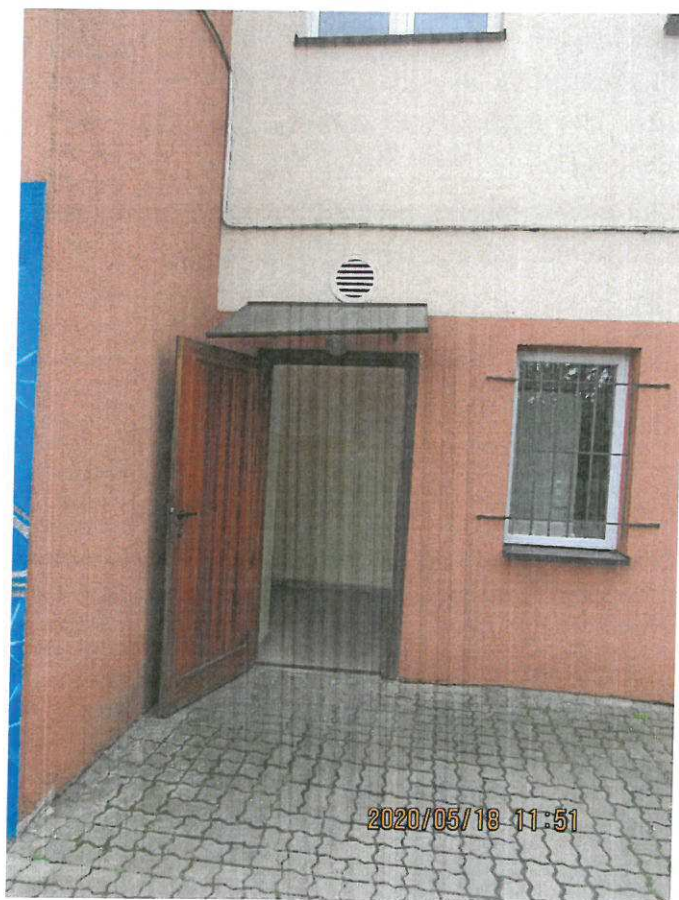
Zdjęcie nr 1 – Wejście do budynku
