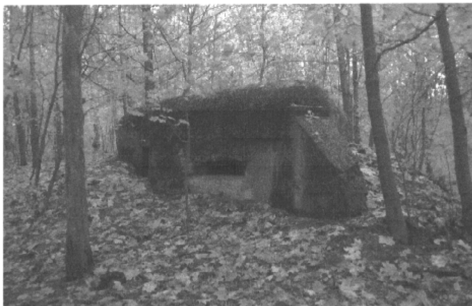
Schron z 1939 r. znajdujący się na trasie szlaku turystycznego Umocnień Przedmościa Bydgoskiego
